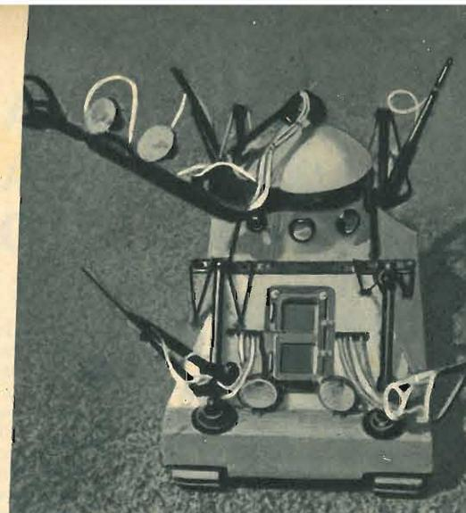
● Modello del carro sottomarino Riesenberg (USA, 1949) Con tre uomini a bordo, questo apparecchio, del peso di 25 t, è provvisto di cinque bracci idraulici che portano diversi attrezzi.
